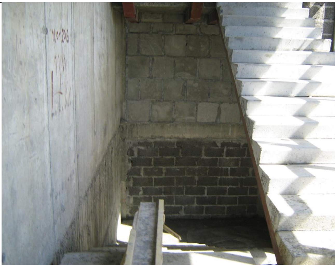
1) Смонтированный лестничный марш
